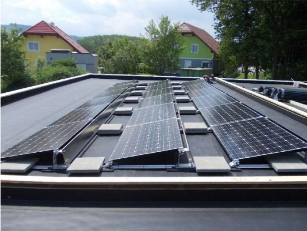
Flachdachlösung mit max. 10 ° Aufständigung und 1,0 M von Traufe und Ortgang
