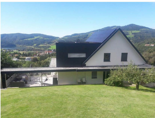
Ins Dach integrierte Anlage, Dachmaterialfarbe in einem ähnlichen Farbton wie die PV-Module:
